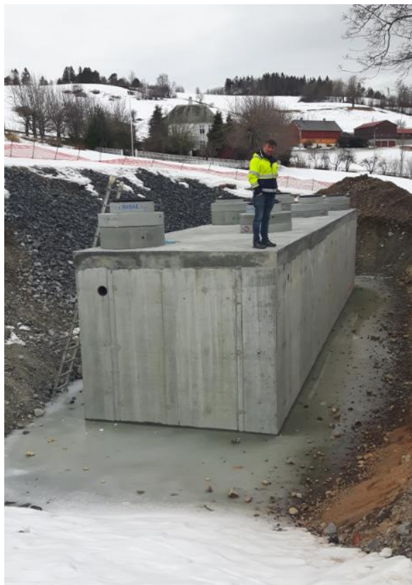
Bilde fra slamavskiller Torvikbukt Vest, under bygging. Foto: Alf Høgset
