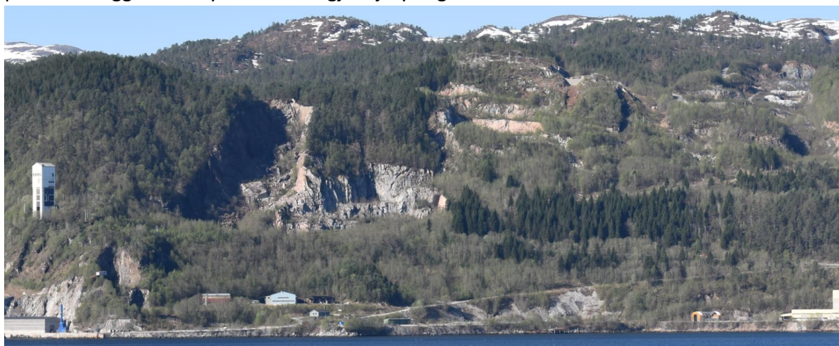
FIGUR 9 STORE SÅR ETTER INNRRASING I GRUVENE OG GRUVEDRIFT I DAGBRUDD. ÅPENBART DÅRLIG FJELL MED MYE SPREKKER. OPPE TIL HØYRE SEES FYLLINGER MED BIG-BAGS (DEPONI 2).
