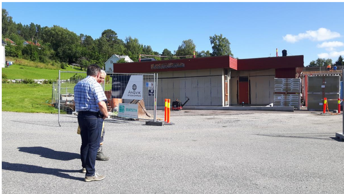
Ordfører Knut Sjømcøling i samtale med entreprenør John Aspaas utenfor byggeområdet på Angvik skule. Foto: Birgit Eliassen
