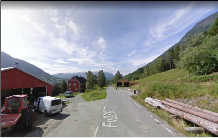
Figur 5-15: Pesetra. Her blir terrenget brattere opp mot Skredfjellet (googlemaps).
